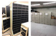
大型ラックやキャビネットを解体搬出
