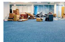
業務エリアの机・椅子・キャビネットを撤去
