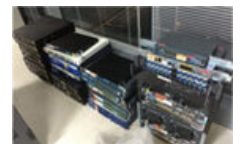
サーバーのアンマウント
