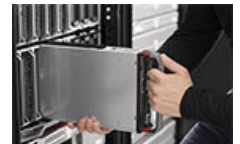
サーバーアンマウント
