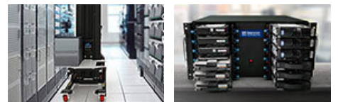
サーバーアンマウント サーバーデータ消去
