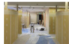
間仕切り工事
