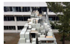
通り廊下から地上に荷卸し
