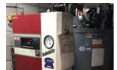
ボイラー等の特殊什器を撤去
