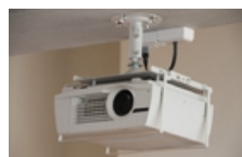
取り外し作業も実施
