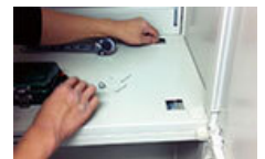
作業員20名で残置物を解体して撤去
